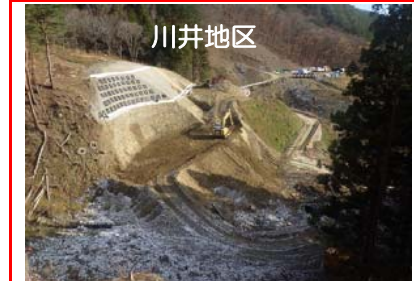
⑧施工：大豊建設
