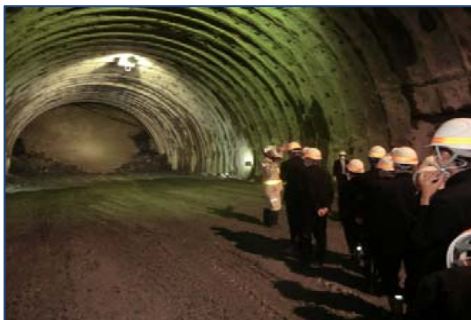
最後にトンネル先端で切羽の状況を説明
