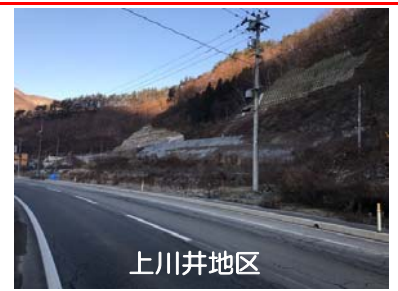
⑨施工：大豊建設
