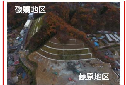
⑤施工：大成建設
