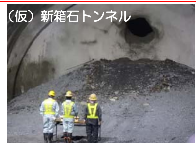
④施工：安藤・間
